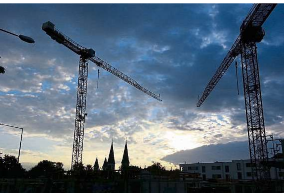
Stille auf den Großbaustellen. Hier im Dirchtviertel, von der Wielandstraße aus gesehen zur Dreifaltigkeits- und Lutherkirche. Foto: Otto Seckler
