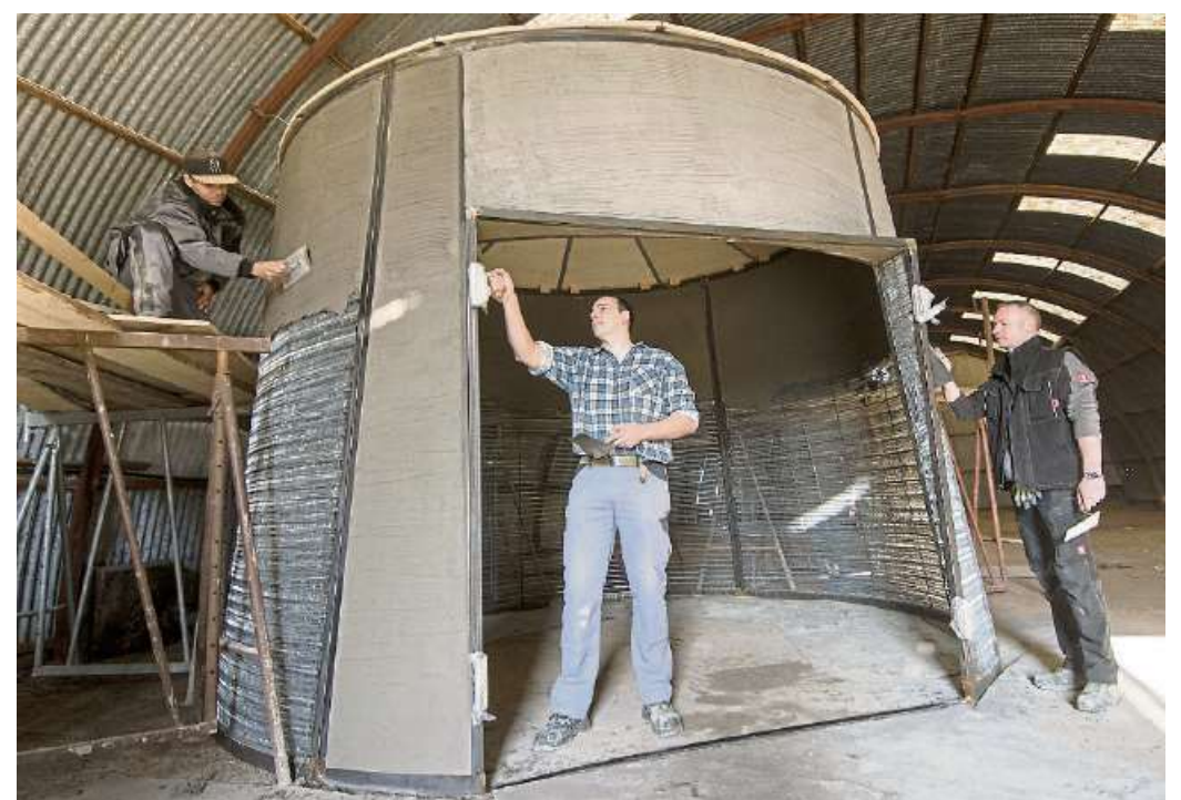
Geschäftsführer Jörg Bourgett hat sofort zugesagt, dass die Langzeitarbeitslosen in Beschäftigungsprogrammen der Wiesbadener Jugendwerkstätten den „Pavillon der Stille“ bauen werden, der Ende April auf dem Schlossplatz aufgestellt wird. In der Domäne Mechtildshausen arbeiten unter anderem Jeffrey Berghäuser, Coach Waldemar Martens und Peter Heflik an dem Projekt. Foto: wita/Uwe Stotz
